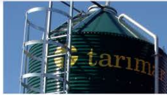
Korumalı Silo Merdiveni
